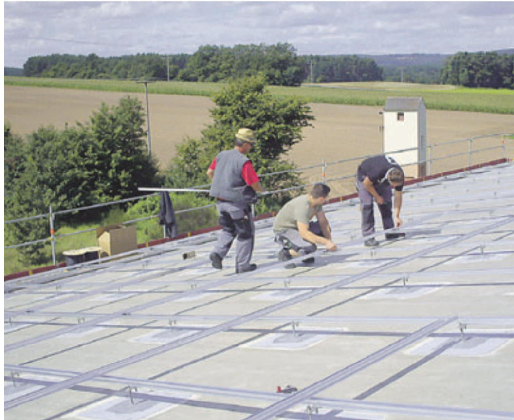
NEU: Montagesystem für Folien- und Bitumendächer, sowohl aufgeständert als auch Aufdach.
